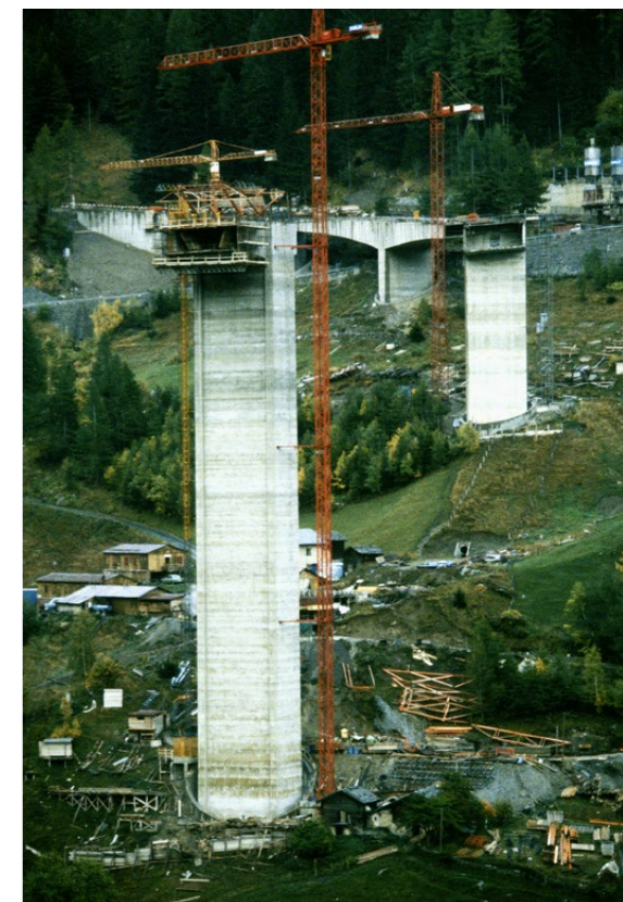
Auf der linken Talseite ist die zweite Hauptstütze auf Lagern gestellt, um sie nachstellen zu können. Es waren schweizweit die schwersten Lager, die damals verbaut wurden.
