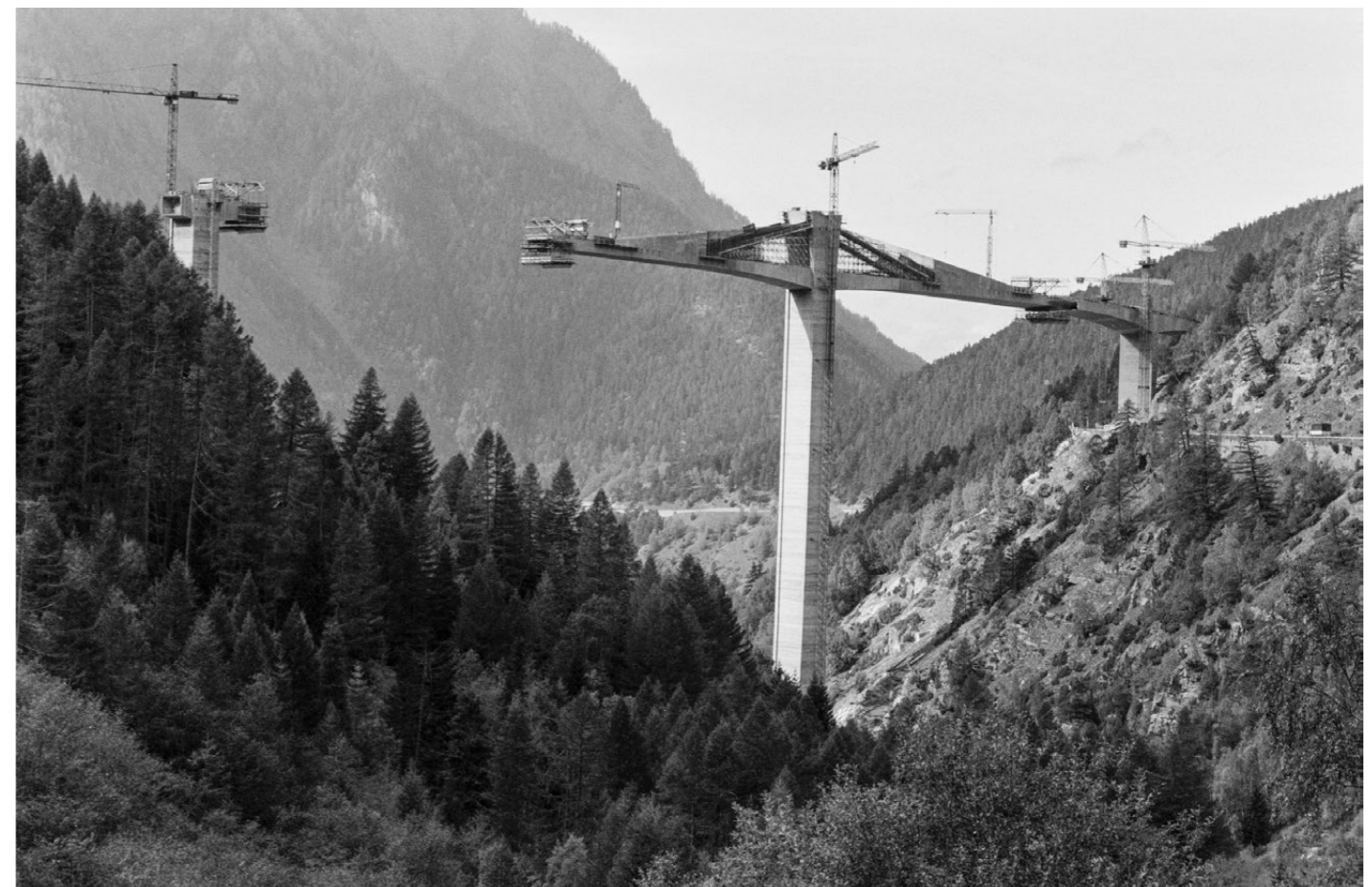
Im Herbst 1979 war der gesamte Unterbau und rund 60 Prozent des Überbaus erstellt. Bild: Der Vorbau vom Hauptpfeiler in Richtung rechter Talseite erreichte damals schon fast die Bauarbeiten in entgegengesetzter Richtung.
