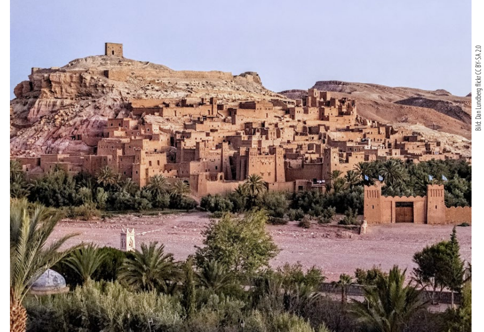
Durch das Erdbeben wurden laut Berichten 27 historische Stätten beschädigt, hauptsächlich in Marrakesch, Taroudant und Ouarzazate. Darunter auch die Unesco-Weltkulturerbe-Stadt Ait Ben Haddou, die zu grossen Teilen aus Stampflehm besteht – in diesem Bild ist sie noch unversehrt.
