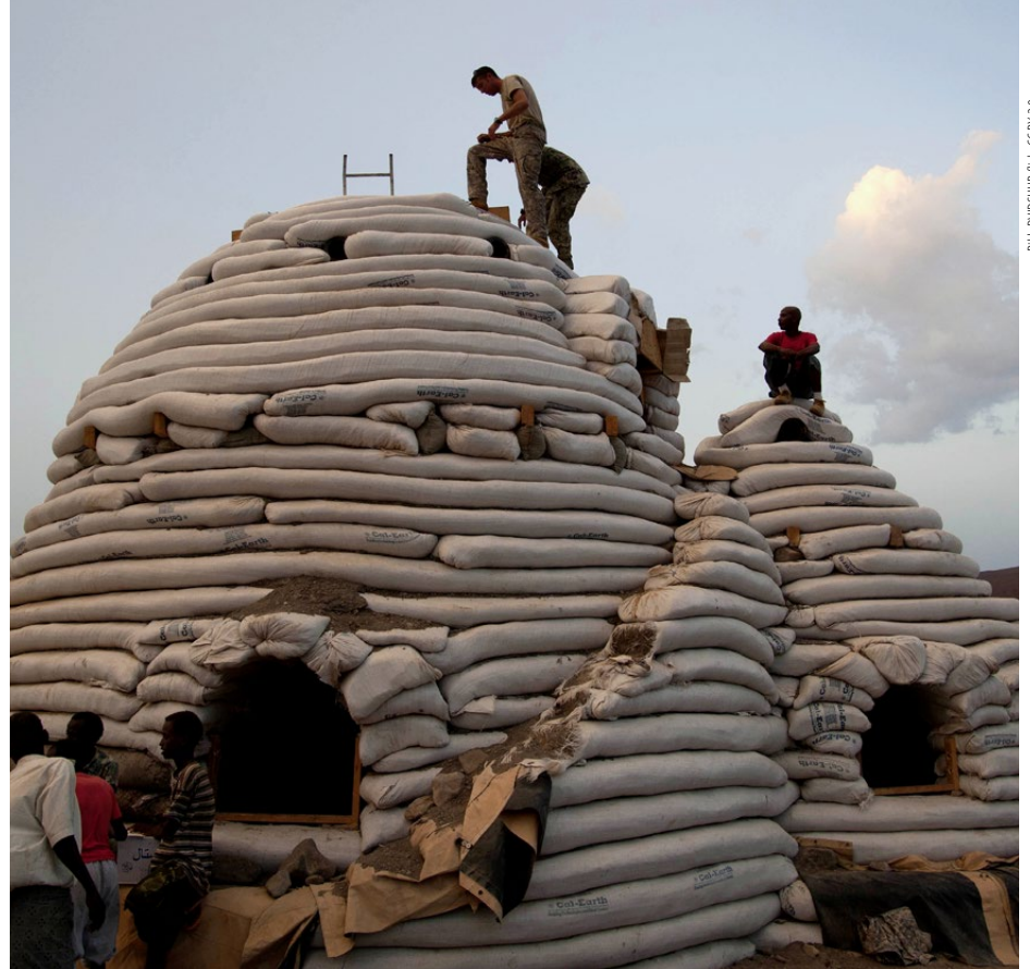
Die bienenstockförmigen «Super Adobe»-Strukturen verwenden Kragbögen, -kuppeln und -gewölbe. Im Bild: Einwohner bauen im abgelegenen Dorf Karatbi San in Dschibuti ein Haus.
