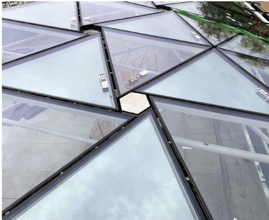
Die sphärisch gewölbte Dachkonstruktion besteht aus grösseren Dreiecksflächen aus Glas und kleineren Sechsecksflächen aus Metall, die über gerade Profilstücke miteinander verbunden sind.
