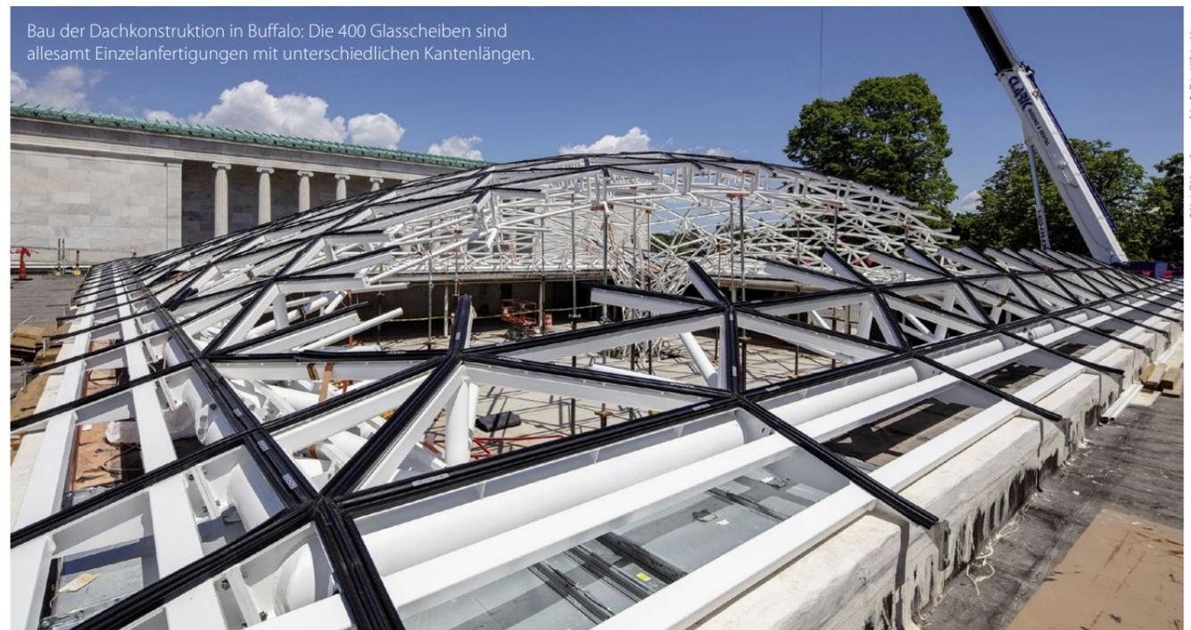
Bau der Dachkonstruktion in Buffalo: Die 400 Glasscheiben sind allesamt Einzelanfertigungen mit unterschiedlichen Kantenlängen.
