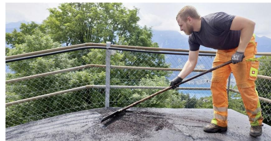
Angenehm für den Bauarbeiter vor Ort: Ausbessern eines Belagschadens mit Kaltasphalt bei einer Schulung im bernischen Beatenberg.
