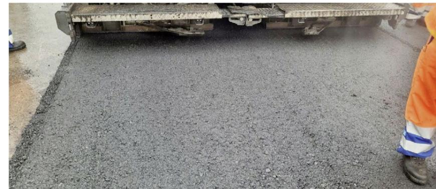
Projekt des Tiefbauamtes Basel: Mit Bio-Char angereicherter Asphalt für eine Strassensanierung – allerdings heiss eingebracht.
