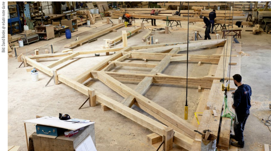
Die Teile des Dachstuhls werden zuerst liegend zusammengefügt. Erst danach erfolgt die probeweise Aufrichtung.
