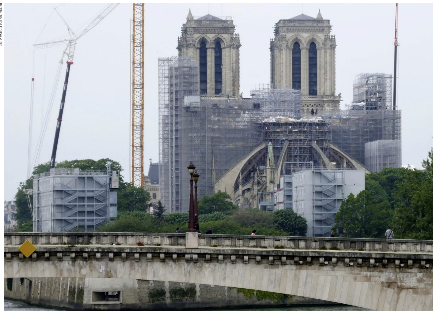
Die Restaurierungsarbeiten sind in vollem Gange. Die Malereien in den Kapellen haben ihren ursprünglichen Glanz bereits zurück erhalten.
