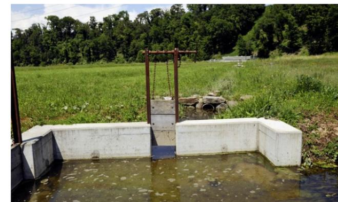
Schleusen bei den Wässerwiesen verteilen das Wasser in die Kanalverzweigungen.
