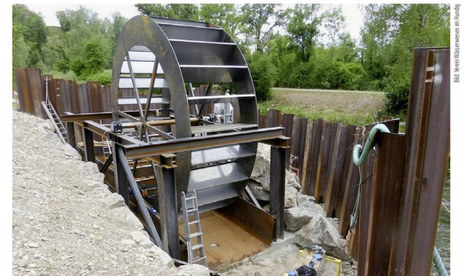
Installation des acht Tonnen schweren Ungetüms hinter Spundwänden. Um den Wirkungsgrad zu erhöhen, erhielt die darunter liegende Stahlrinne noch eine zusätzliche Vertiefung.
