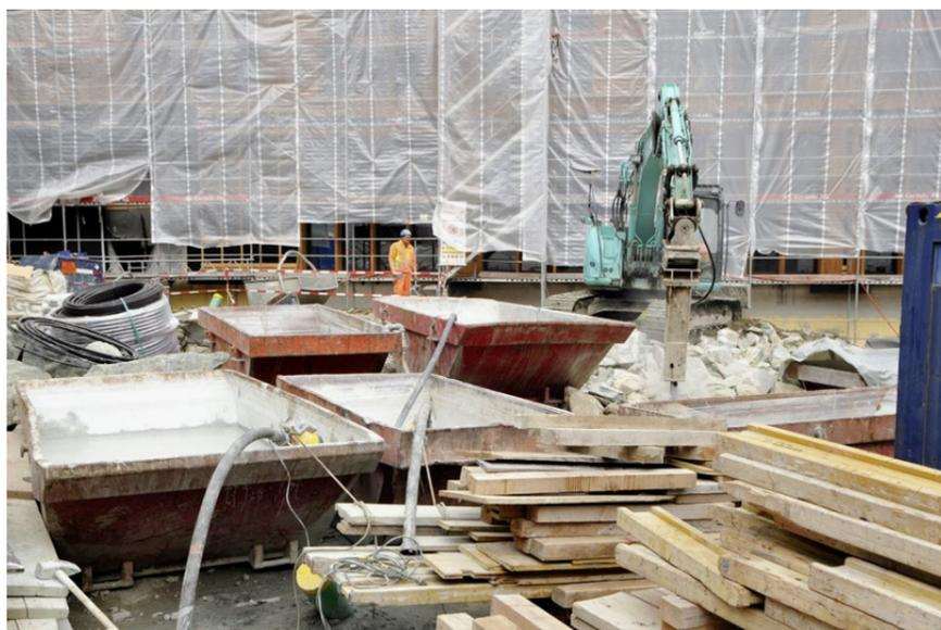
Der Bohrrückfluss bleibt in diesen Mulden stehen, bis sich genügend Schwebstoffe abgesetzt haben. Erst dann kann das Wasser zur Aufbereitung weitergeleitet werden.
