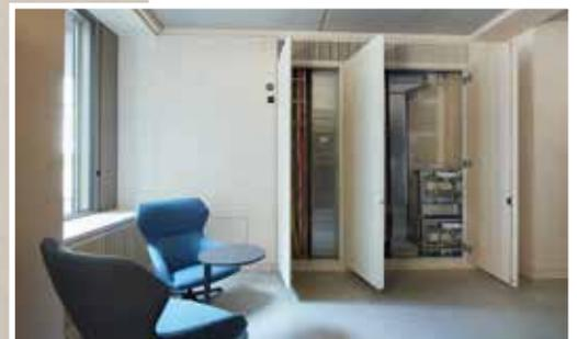
«GIFAdoor» schliesst Steigzonen brandsicher, sorgt für Schallschutz und für viele Gestaltungsmöglichkeiten.
