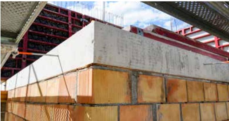
Mit dem UNI-Fix-Dachrandhalter erhält der Planer und Architekt ein System, mit dem Flachdachränder und Terrassenabschlüsse sehr schlank und stabil erstellt werden können. Der Gestaltung der Terrassenabschlüsse und der Flachdachränder mit dem UNI-Fix System sind fast keine Grenzen gesetzt.
