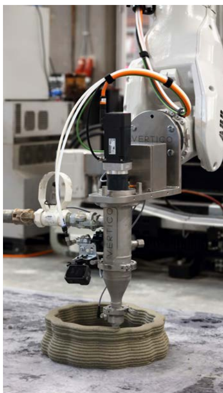
Der Ausdruck der Betonsäule hat begonnen.
