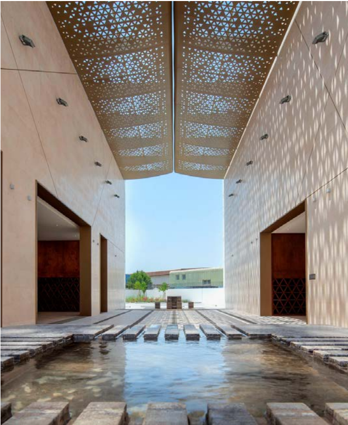
Getrennt sind die beiden Gebäudeteile durch eine halboffene Passage, die ein Aluminiumdach beschattet. Natursteinquadern erlauben eine Überquerung des Beckens.
