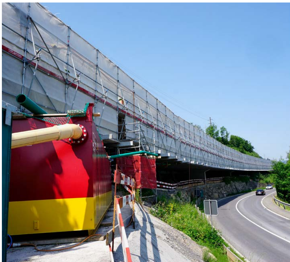
Für die GSAs mussten Aufschüttungen erfolgen, die ausreichend stabil sind.
