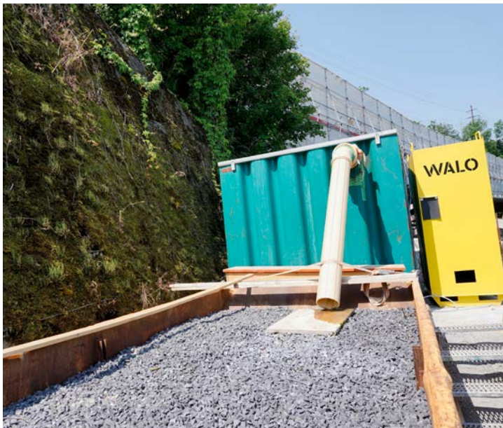
In einer mit Kies gefüllten Filtermulde werden auch die letzten Feinstoffe, die das Wasser trüben, herausgefiltert.
