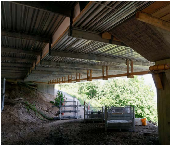
Ein unter den Brücken montiertes Metallgerüst fängt das Bauabwasser auf. Über Rohre wird es kontrolliert in die GSA eingeleitet.
