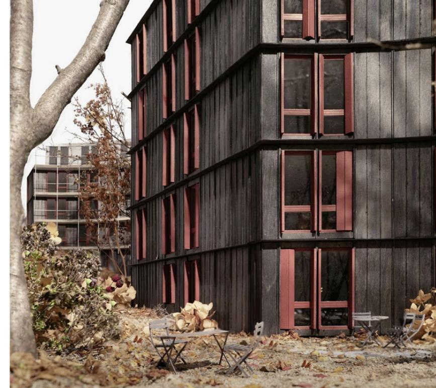
Visualisierung des Siegerprojekts «Voliere». Die Fassade soll in seriell vorgefertigten Holztafelelementen ausgeführt und mit Klapppläden ergänzt werden.
