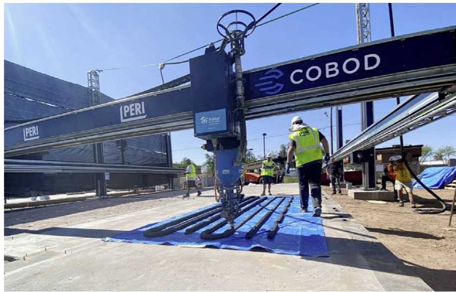
Auch in den USA realisierte Peri bereits Projekte. Im Bild: Einrichtung des Druckers in Tempe, Arizona, für den Druck eines Einfamilienhauses. Die Kalibrierung muss nur ein einziges Mal erfolgen.
