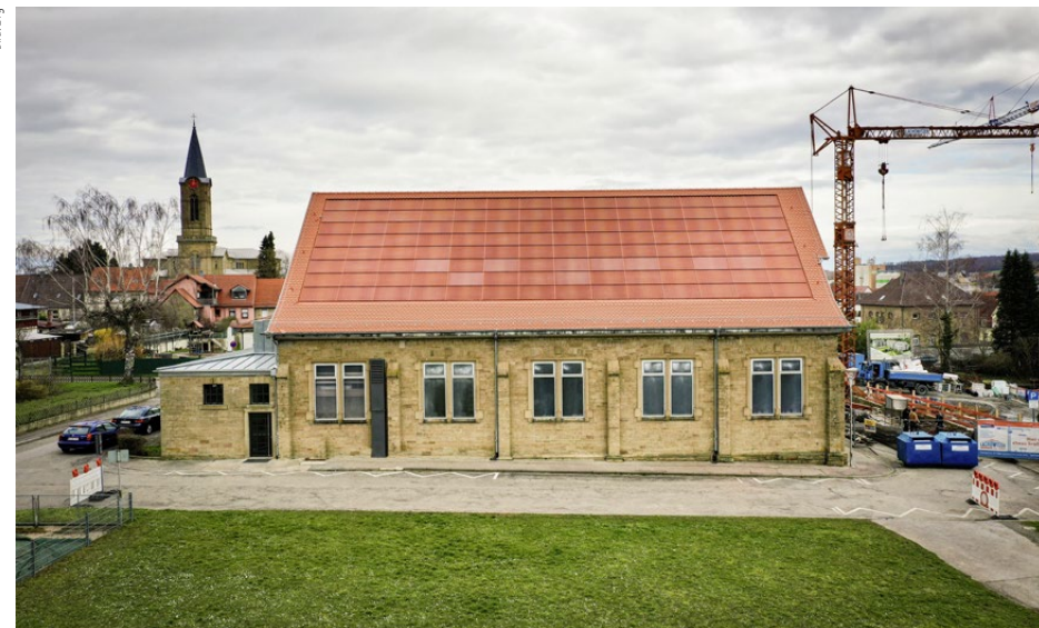
Dächer bestimmter denkmalgeschützter Gebäude bieten zwar auch Potenzial für die Produktion von Solarstrom, doch darf der bauhistorische Bezug zur Entstehungsperiode nicht allzu stark beeinträchtigt werden. Das Fraunhofer-Institut ISE forscht an Lösungen.
