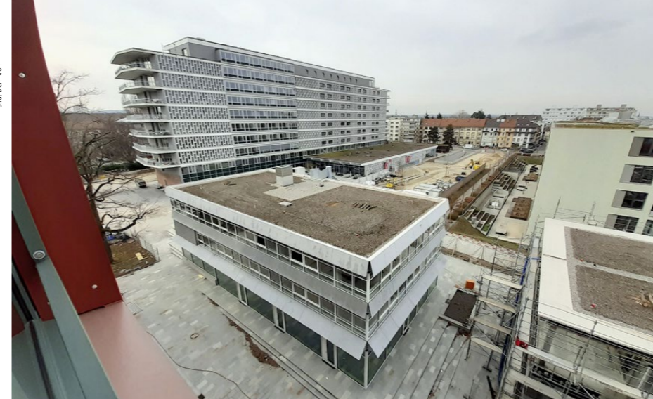
Die Nordseite des fertig sanierten Felix-Platter-Spitals, im Vordergrund ist einer der drei neuen Pavillons zu sehen, rechts eine Ecke des Spitalneubaus.
