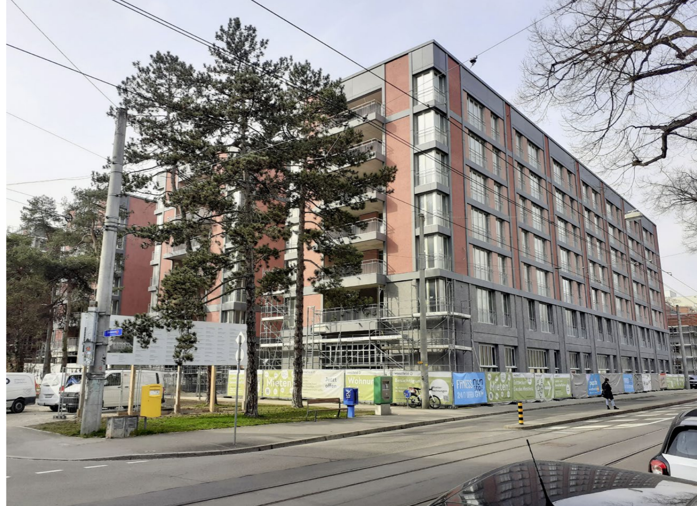
Der Gebäudeteil zur Burgfelderstrasse und Tramlinie hin wurde als erster fertiggestellt.
