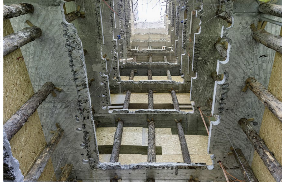
Blick in den Liftschacht: Auch dieser Teil wurde zur Erdbebenertüchtigung des Gebäudes verstärkt.
