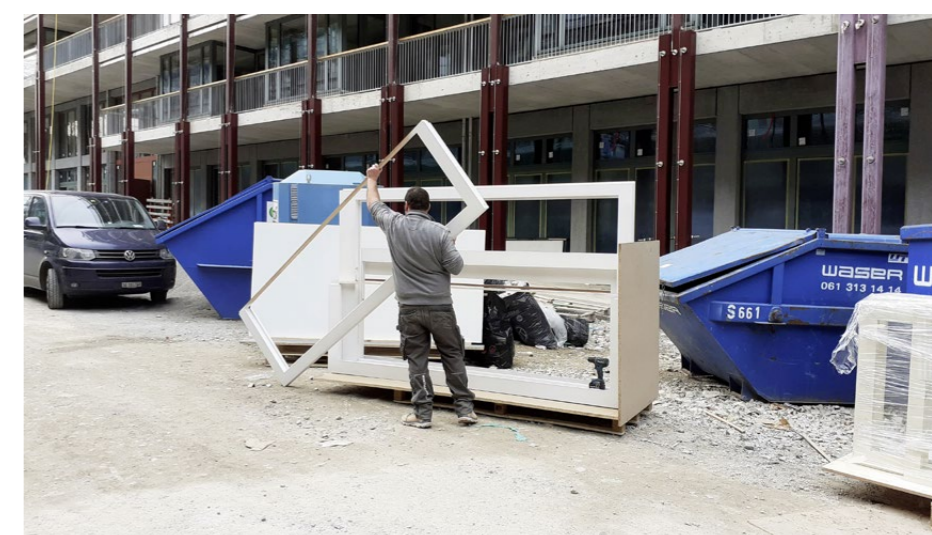
Der Innenausbau ist im Gange: Die fünf Gebäudeteile werden gestaffelt fertiggestellt, danach folgt noch bis 2026 eine weitere Bauetappe.
