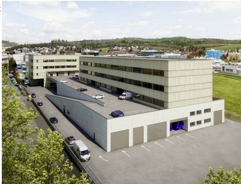
In Zofingen entsteht ein grosser Gebäudekomplex, in den Aargau Verkehr einziehen wird.
