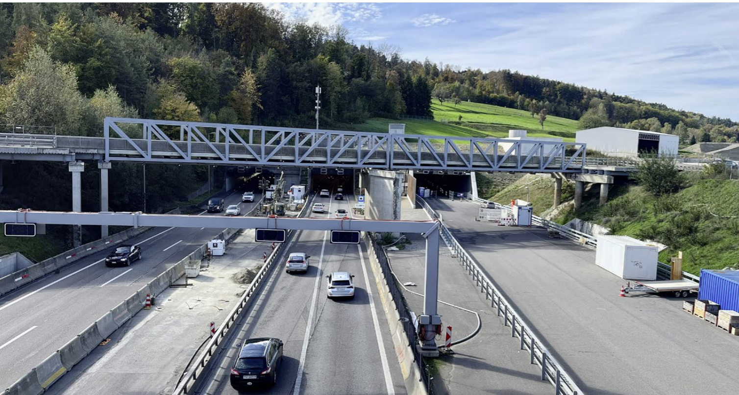
Mit der Eröffnung der dritten Gubrist-Röhre mit neu drei Spuren wird die Verkehrssituation in Richtung Bern entlastet.
