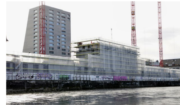
Neue Wohnüberbauung Hard in Zürich: Die Stadt baut auf dem Areal des ehemaligen Tramdepots, direkt an der Limmat.
