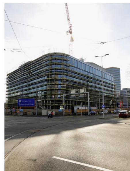
In Oerlikon steht der Neubau der Garage Nord des Autohändlers Emil Frey AG.
