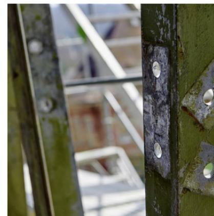
Detail der Aussenfassade, die aus alten Profilen von Strommasten gebaut wurde.
