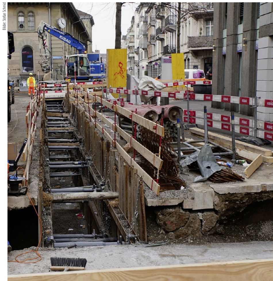
Im Quartier Aussersihl werden die Leitungen zuerst entlang der Hauptverkehrsachsen zu einem Ringschluss verlegt wie hier an der Dienerstrasse. Später werden nach und nach die Querstrassen erschlossen.
