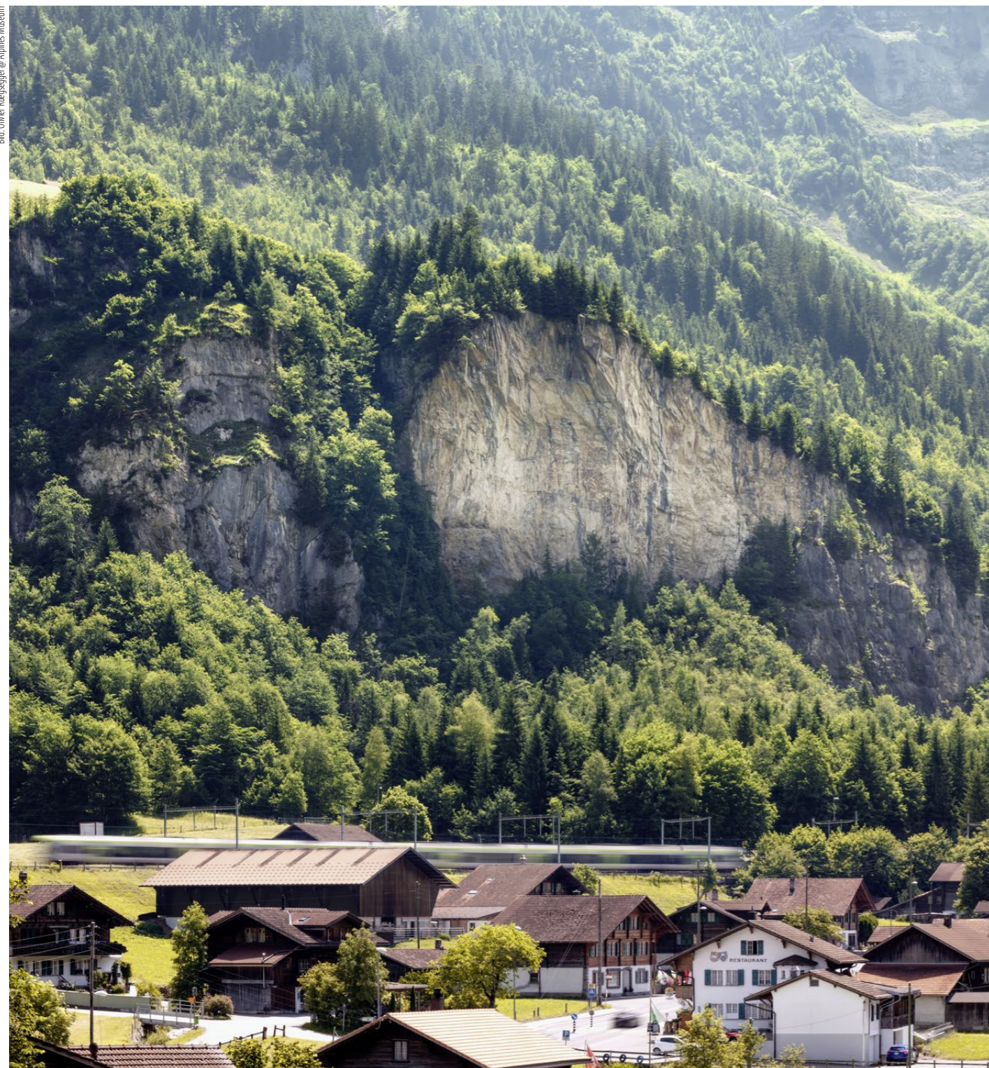
Noch heute ist zu sehen, welch grosser Teil des Felsens oberhalb des ehemaligen Munitionslagers in der Katastrophennacht eingestürzt ist.
