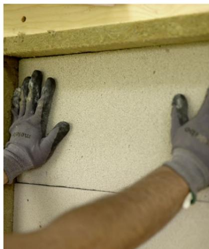
Montage der Dämmplatten auf der Fassade an einem Gebäude im Zürcher Oberland.
