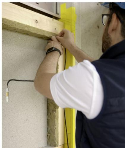
Anbringen von Messinstrumenten zur langfristigen Qualitätssicherung des FenX-Dämmmaterials.
