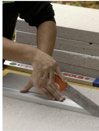
Zuschneiden des FenX-Dämmmaterials mit einer Fuchsschwanzsäge.
