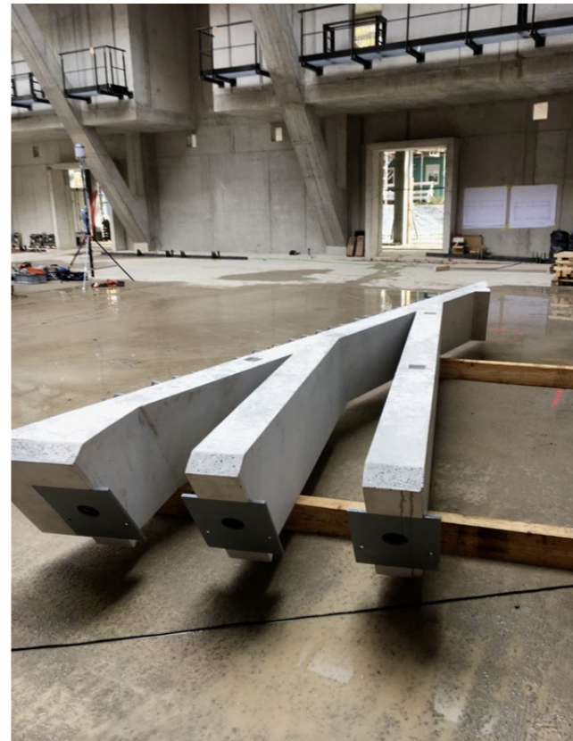
Ein kleineres Fertigteil vor dem Einbau. Es ist für eine Raumecke bestimmt.
