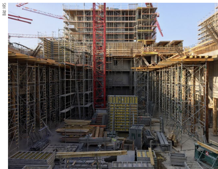
Der Rohbau des Kongresssaals besteht aus senkrechten Wandflächen, die auf vorkragenden Deckenflächen zunehmend nach innen verspringen.
