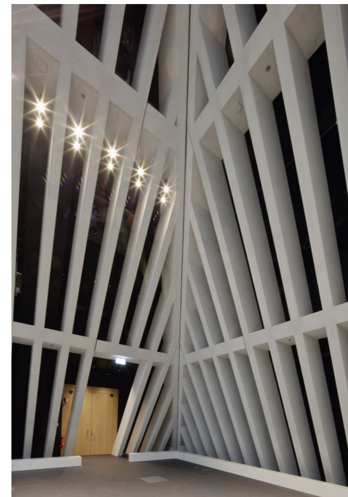
In die Untersichten der Horizontalstreben der Betonfertigteile wurden LED-Strahler, respektive Pendelleuchten-Dosen eingelassen.
