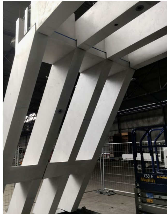
Die eingestellte Konstruktion besteht aus insgesamt 77 Betonfertigteilen, die jeweils vier Betonsparren breit sind.
