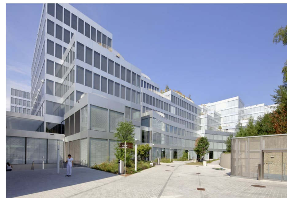
An der Aussenfassade des Kongresszentrums ist die Architektur des grossen Saales nicht ablesbar. Rechts im Bild die Talstation der Butzenbühlstandseilbahn.
