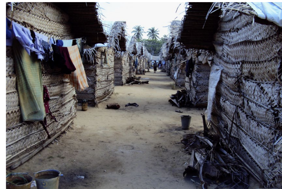
Notunterkünfte aus geflochtenen Kokosmatten in Sri Lanka: Wenn möglich baut man mit lokal vorhandenen Materialien und den Einheimischen bekannten Methoden.
