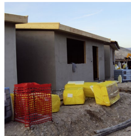
Bau von Holzhäusern im italienischen Aquila, das von einem Erdbeben weitgehend zerstört worden war.
