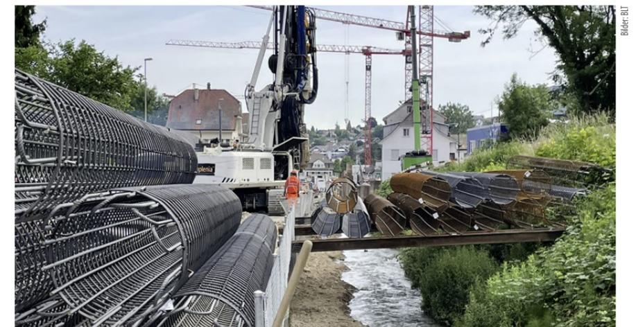
Vorbereitungen zum Abteufen der Bohrpfähle: Diese dienen als Fundament für die Tragplatte der Bahn in Niederdorf.
