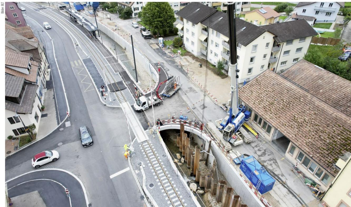
Bahn und Hochwasserschutz in Niederdorf sind fertiggestellt, inklusive der neuen Brücke. Jetzt können die letzten Spundwände rückgezogen werden.
