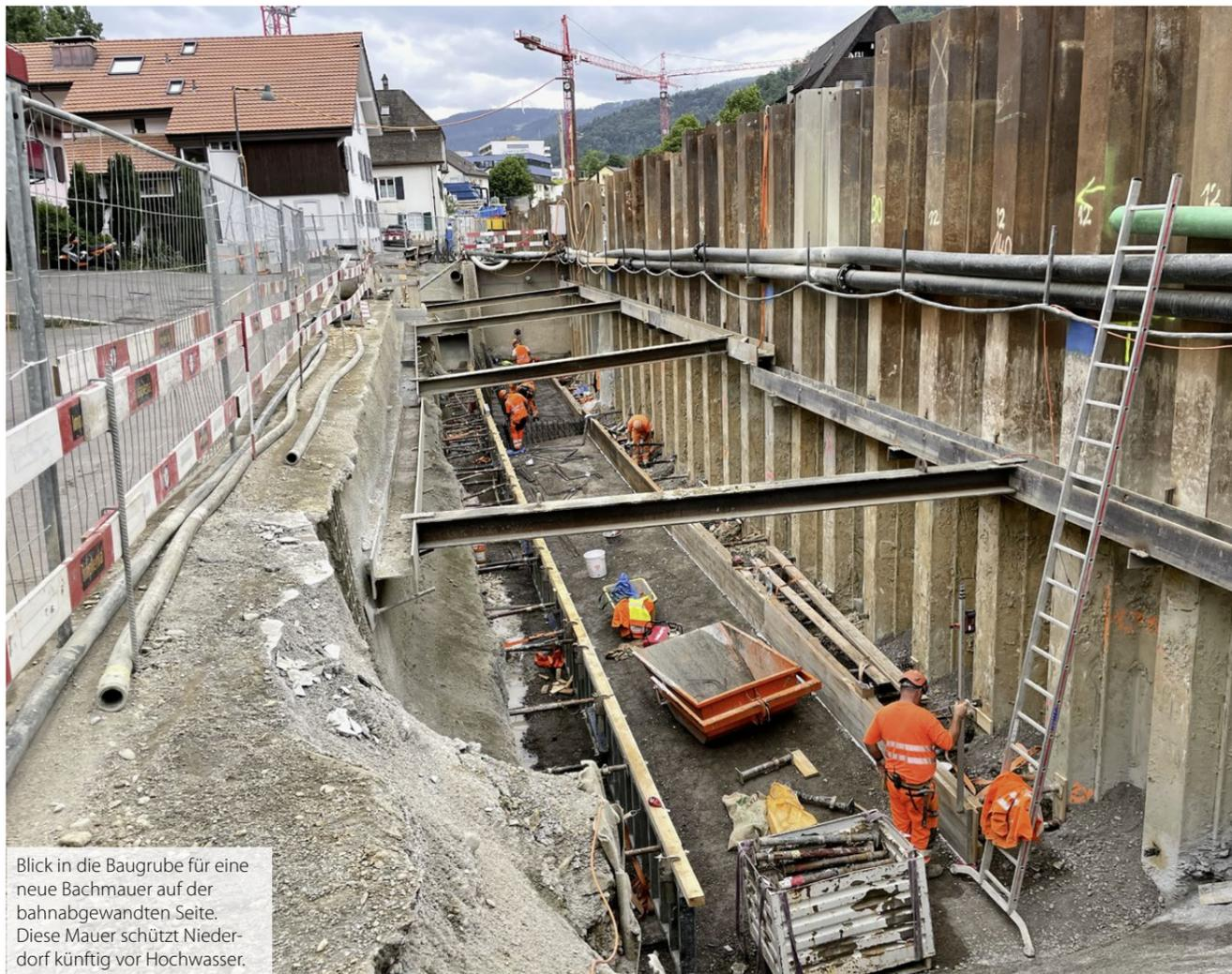
Blick in die Baugrube für eine neue Bachmauer auf der bahnabgewandten Seite. Diese Mauer schützt Niederdorf künftig vor Hochwasser.
