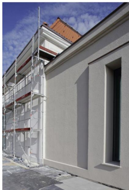
Übergang von Halle 4 zu Halle 3. Die Putzarbeiten an Halle 4 sind bereits abgeschlossen. Bei der Außenfassade von Halle 3 ist noch die Gewebematte zu erkennen. Das Aufbringen des obersten Deckputzes steht unmittelbar bevor.
