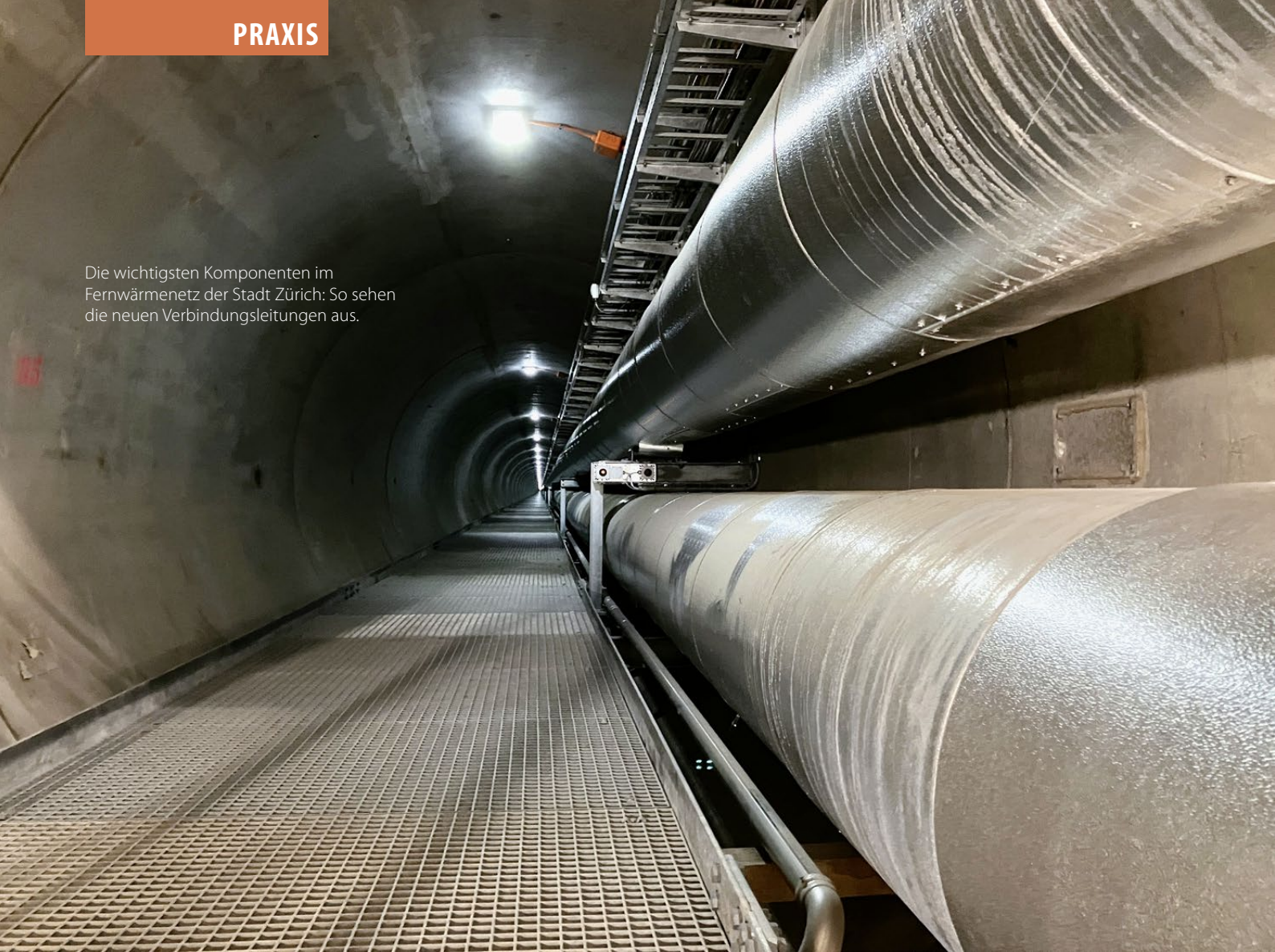
Die Schnittstelle für die Quartierserschliessung: Aus diesen Abzweigerohren fliesst das Wasser aus den Verbindungsleitungen in die Quartiere.
