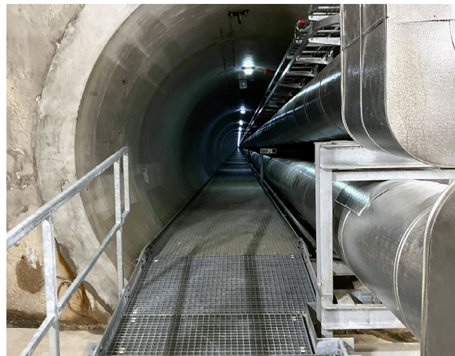
So sehen die neuen Verbindungsleitungen zwischen der KVA Hagenholz und Zürich-West aus.
