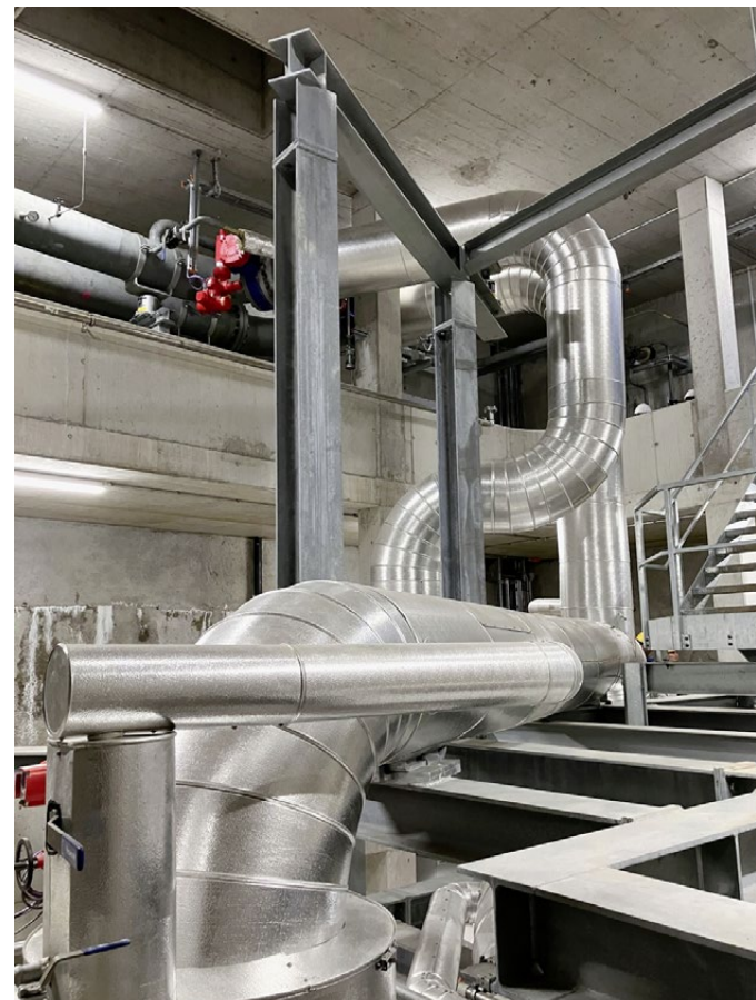
Die Schnittstelle für die Quartierserschliessung: Aus diesen Abzweigerohren fliesst das Wasser aus den Verbindungsleitungen in die Quartiere.
