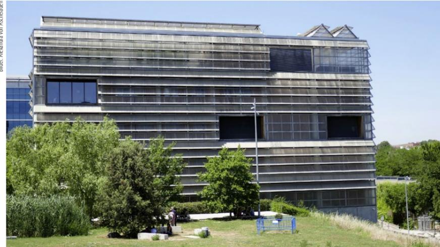
Die Fassade reguliert die Temperatur im Inneren selbsttätig. Zwischen Lamellen und Gebäude befindet sich ein Zwischenbereich, der als Wärmepolster fungiert.
