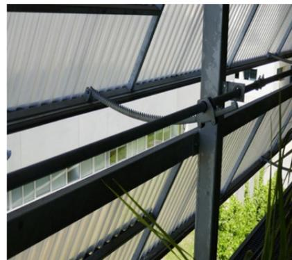
Die Fassade öffnet und schliesst ihre Lamellen automatisch je nach Temperatur, Luftfeuchtigkeit, Wind oder Sonneneinstrahlung.
