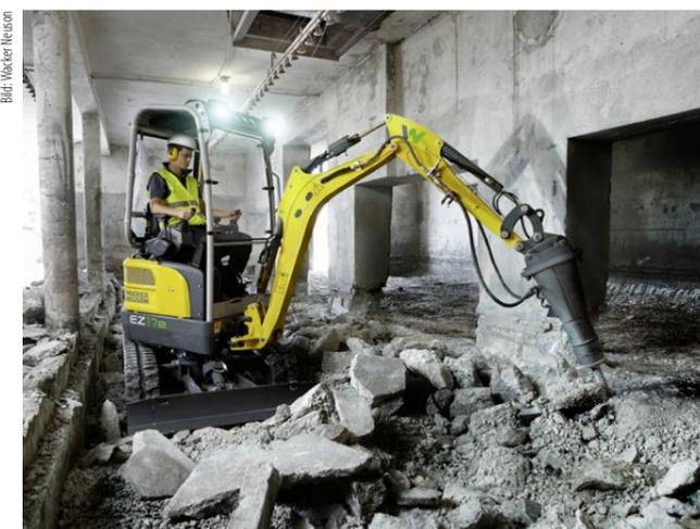
Der vollelektrische Minibagger Wacker Neuson EZ17e bezieht seine Energie aus einer bordeigene Lithium-Ionen-Batterie.
