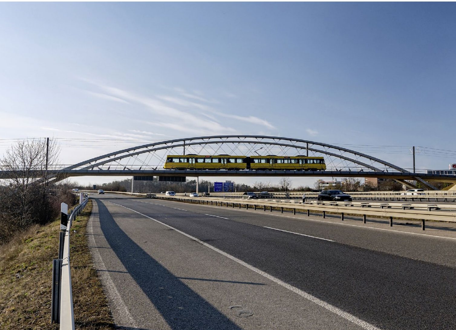
Beinahe 130 Meter lang und rund 1500 Tonnen schwer: Die Stadtbahnbrücke bindet Stuttgart besser an den Flughafen an.
