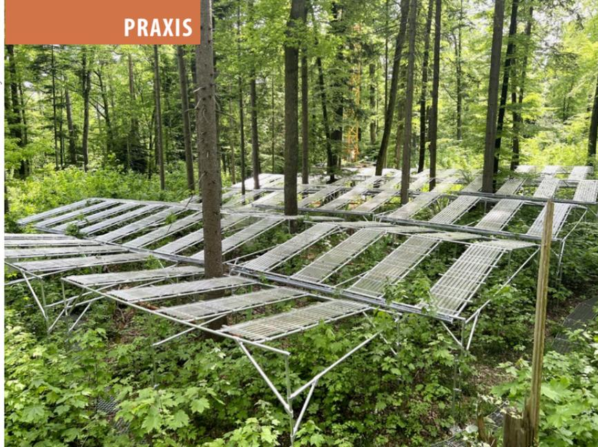
Sicht von oben auf eines der Teildächer. Die sechs Meter langen Dachstreben müssen zwischen den Bäumen montiert werden. Wächst einer krumm, muss die Planung angepasst werden.
