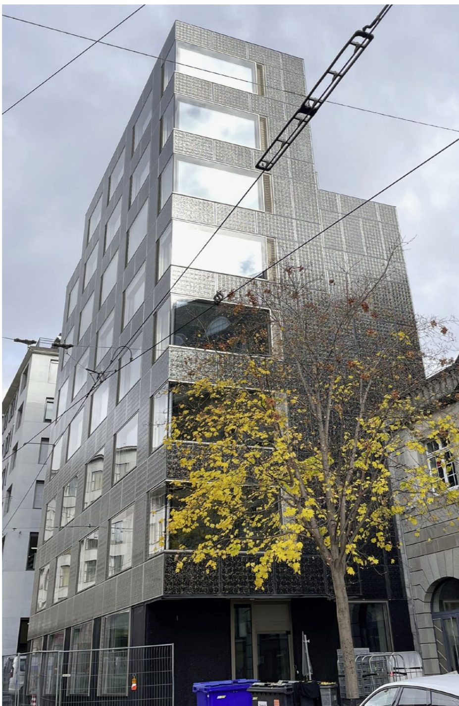
Ein Leuchtturm-Projekt in Sachen Nachhaltigkeit: Die neue Heimat des AUE in Basel.
