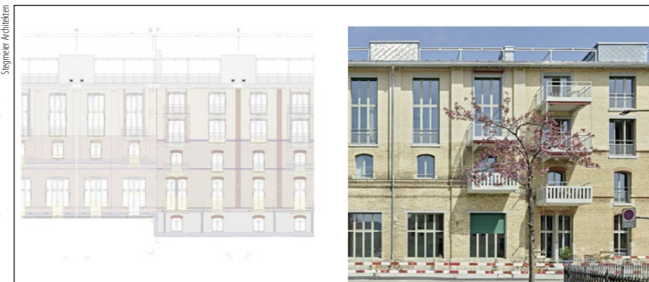
Hinter der ergänzten Klinkerfassade versteckt sich bei den Stadthäusern in der Lokstadt Winterthur eine Tragstruktur aus Holz.
