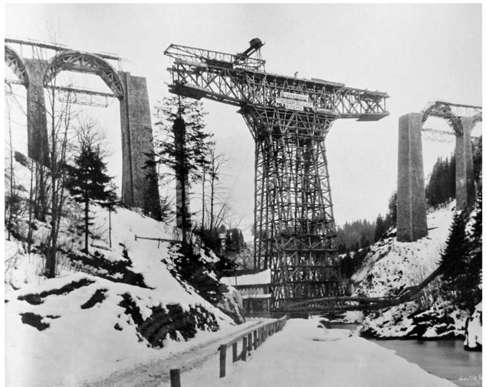
Beim Sitterviadukt (1909) wurde auf einem 94 Meter hohen Gerüsturm eine 120 Meter weit spannende Stahlbrücke erstellt.
