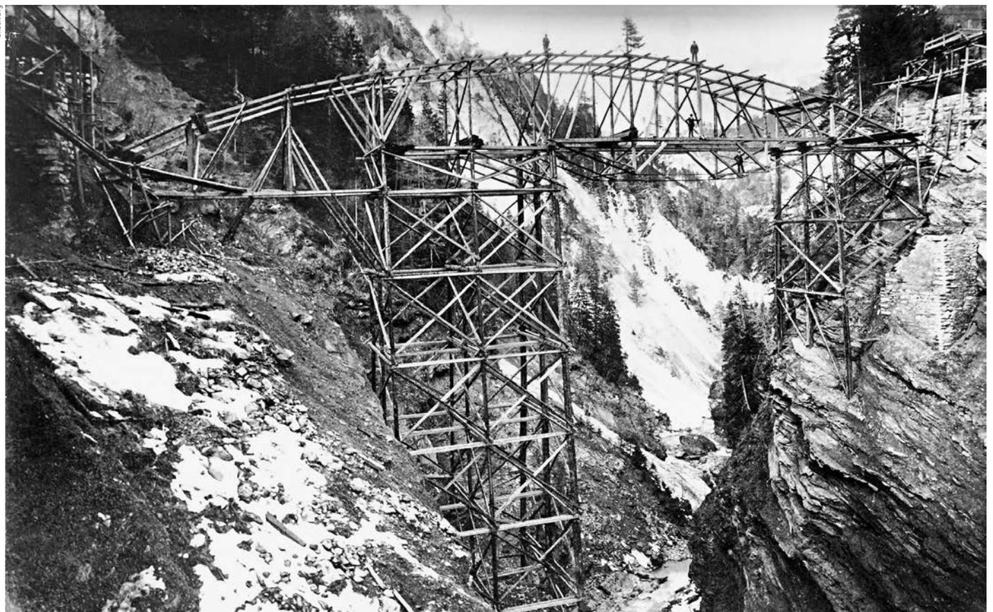
Auf dem Bild ist das Lehrgerüst der Versamer Tobelbrücke bei Flims zu sehen. Es war das erste Lehrgerüst von Richard Coray und das einzige, das er mit einer Sprengung entfernte.
