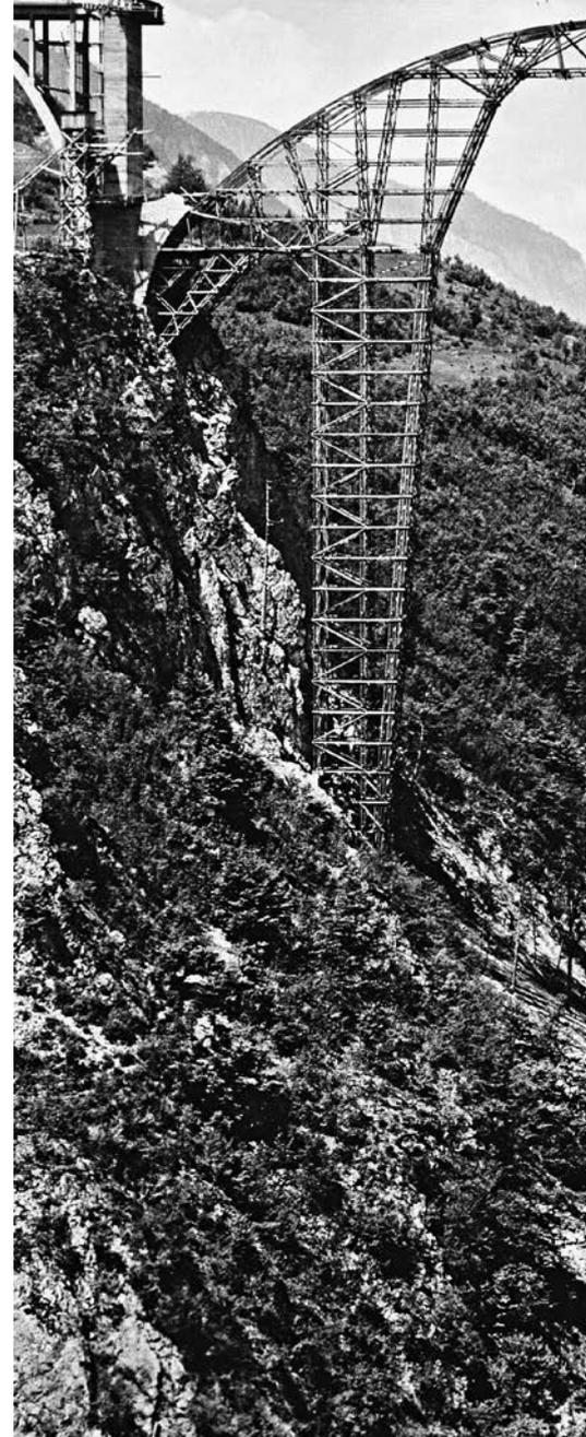
von Hand mit Säge und Axt. Um ein vorzeitiges Verziehen der fertig angepassten, jedoch noch frischen Hölzer zu vermeiden, wurden diese bis zu ihrer Montage mit feuchten Tüchern bedeckt.
