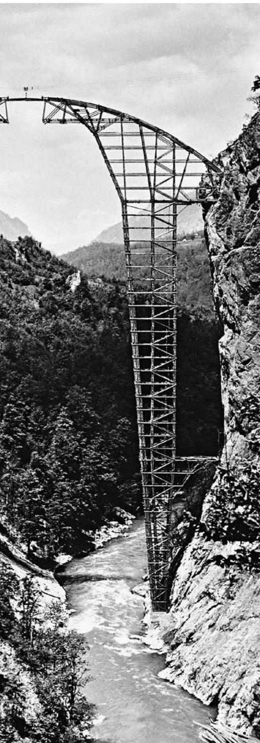
das Prinzip der von seinem Vater entwickelten Gerüstabsenkung zu erläutern. Denn grundsätzlich müssen brückenträgende Lehrgerüste so angelegt sein, dass diese demontierbar sind. Das Problem ist, dass gemauerte oder betonierte Bögen zunächst ein Lehrgerüst belasten, bevor sie selber die Last abtragen. Deshalb müssen die Lehrgerüste erst etwas abgesenkt wer-
