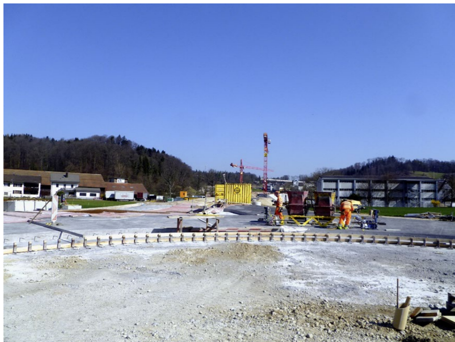
Rund 36,5 Millionen Franken kostet am Ende die zwei Kilometer lange Umfahrung Melligen. Dieser Abschnitt wird bereits im August dieses Jahres dem Verkehr übergeben.
