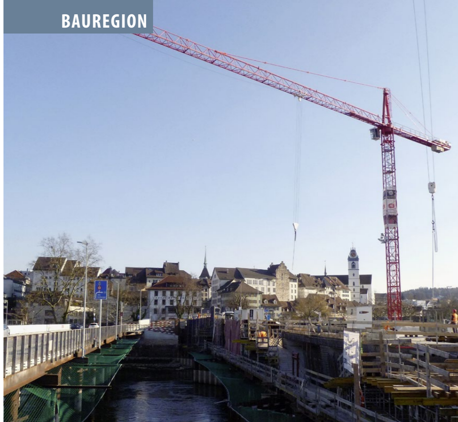
Bauarbeiten am Pont Neuf in Aarau: Die neue Aare-Brücke wird deutlich teurer zu stehen kommen als ursprünglich geplant. Die Eröffnung ist allerdings wie von Anfang an geplant für das nächste Jahr vorgesehen.
