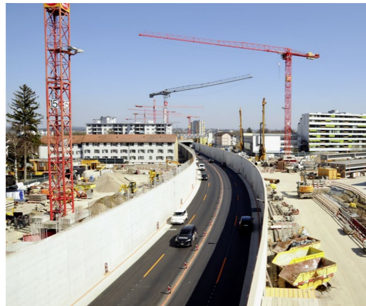
Baustelle Einhausung Schwamendingen: In Kürze erhält die Stadtautobahn ihre Überdachung. Einige der BIM-geplanten Deckenträger liegen bereits am Rand der Baustelle (ganz rechts).
