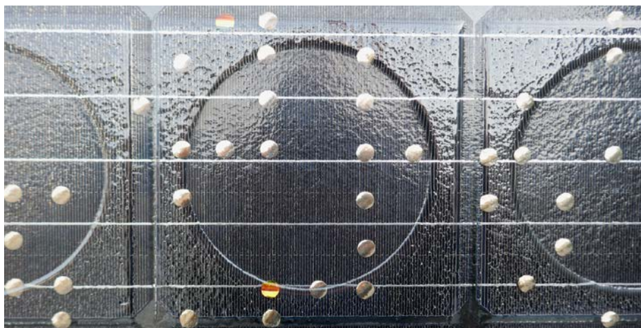
Die Photovoltaikmodule haben eine strukturierte Oberfläche aus gehärtetem Schmelzglas. Auf die Oberfläche wurden in unregelmässigen Abständen goldene Punkte aufgebracht. Durch sie verändert sich je nach Sonneneinstrahlung das Lichtspiel der Module, das sich so in die Umgebung einpasst.
