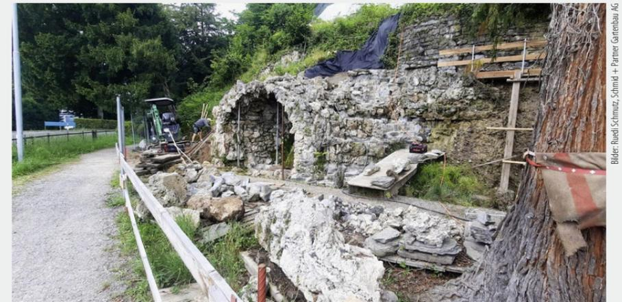
Die Grotte war grossteils überwachsen und wird nun aufwendig wiederhergestellt. Im Winter ruhen die Arbeiten, da der Kalkmörtel nur bei Temperaturen über fünf Grad Celsius verarbeitet werden kann.
