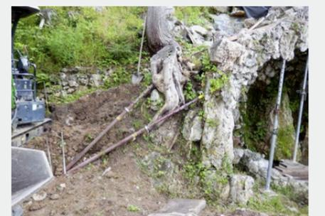
Eine Eibe war die erste grosse Knacknuss bei der Sanierung. Sie wurde im Rahmen der Rodung des Hangs gefällt. Ihr Wurzelstock war ins Gewölbe der Grotte hineingewachsen und musste aufwendig entfernt werden.
