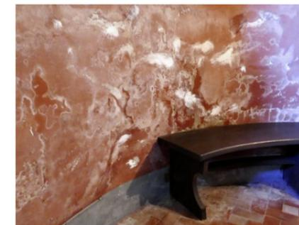
Sorgenkind Trinkhalle: Salzausblühungen bis in Schulterhöhe. Mitschuld hat Zementputz, der in den 1980er-Jahren aufgebracht wurde. Er soll nun durch Kalkputz ersetzt werden, um das Problem etwas einzudämmen.
