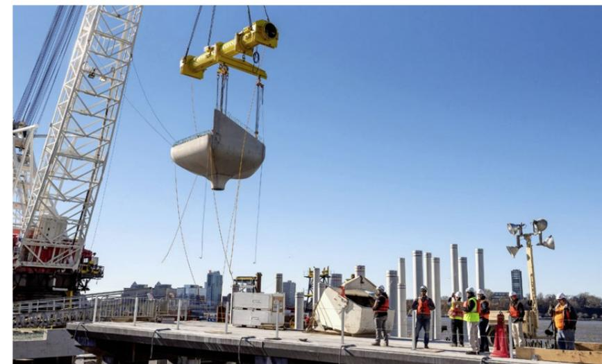
Einer der 132 tulpenartigen Betonfertigteile wird eingehoben.
