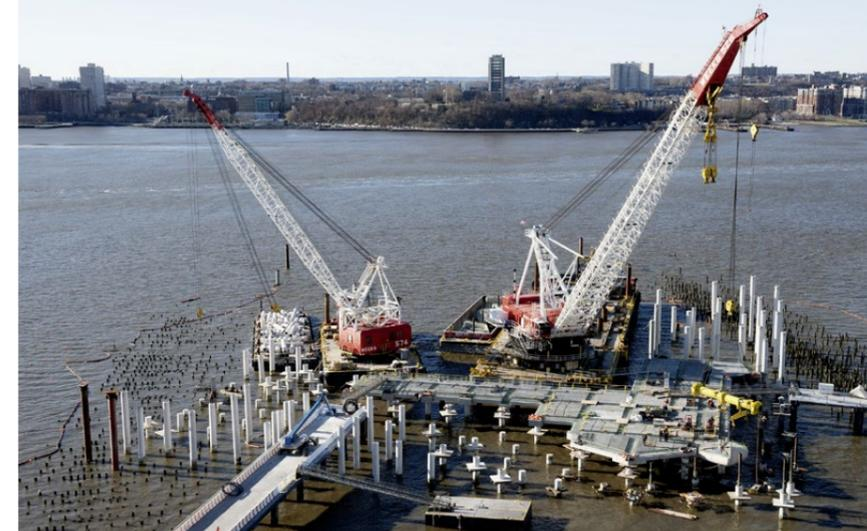
Mit Schwimmkränen wurden zunächst die 267 Spannbetonpfähle in Position gebracht.
