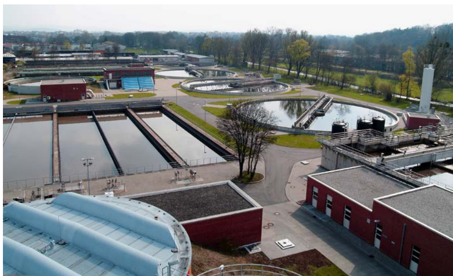
Kläranlagen mit einer vierten Reinigungsstufe können sehr effektiv zur Eliminierung von schädlichen Mikroverunreinigungen eingesetzt werden.
