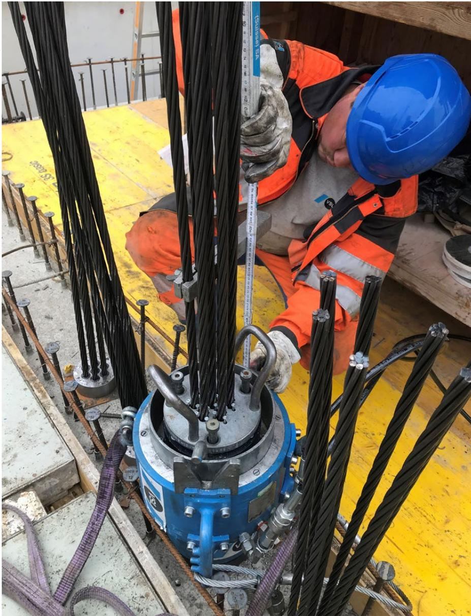
Auf dem elften Stock werden die Litzen mit Spannpressen vorgespannt. Die Kabel werden mit einer Zugkraft von rund 20 Tonnen pro Litze gespannt.
