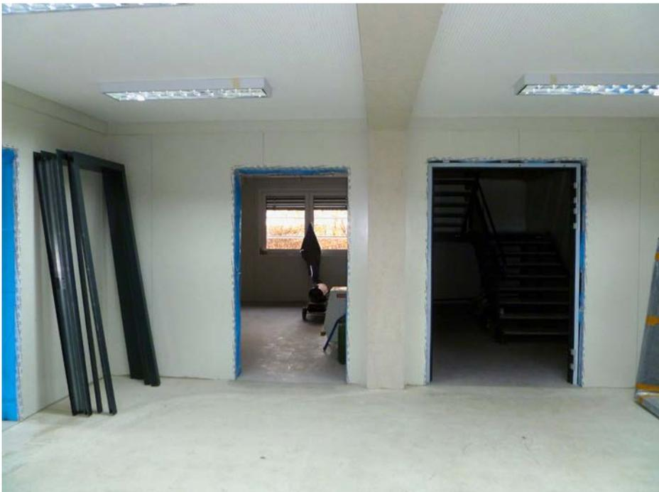
Im zentralen Erschliessungsbereich des zweiten Gebäudes müssen noch die Türen eingesetzt werden. Alle Teile sind vorgefertigt, die Montage geht zügig voran.
