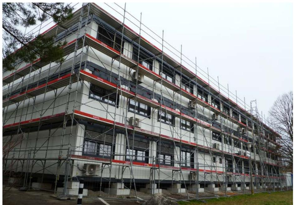
Die Gebäude sitzen auf modularen Fundamentblöcken auf, die vorgefertigt geliefert und nach dem Abbau weiterverwendet werden können.
