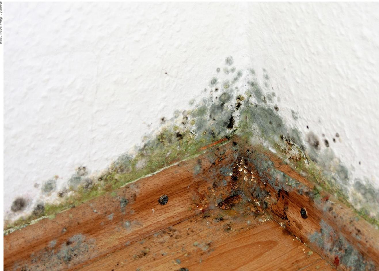
Wenn Handwerker Wände, Dächer oder Fassaden nicht oder falsch abgedichtet haben, kommt es zu Feuchtigkeitsschäden.
