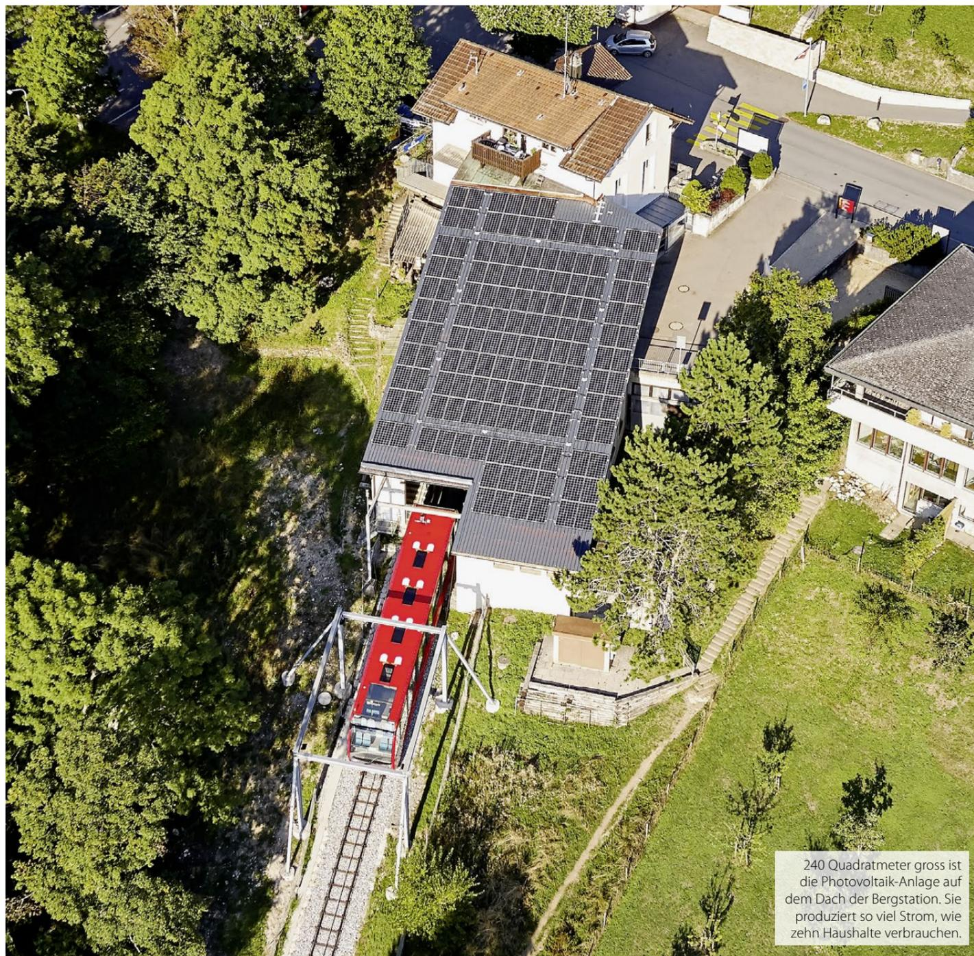
240 Quadratmeter gross ist die Photovoltaik-Anlage auf dem Dach der Bergstation. Sie produziert so viel Strom, wie zehn Haushalte verbrauchen.
