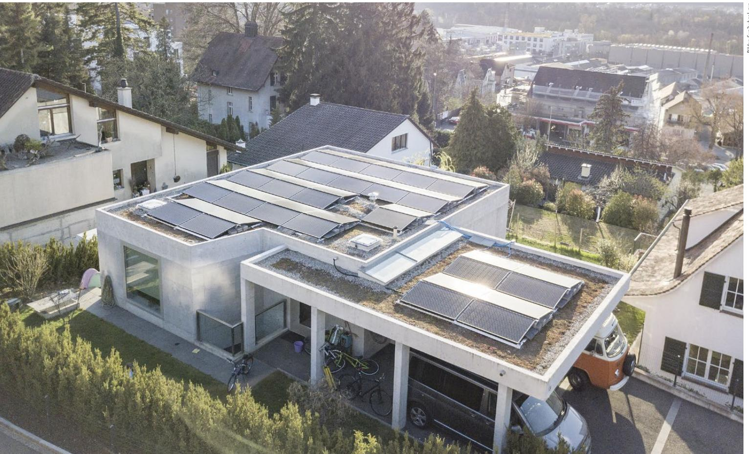
Der eigene Strom aus der Photovoltaikanlage kann mit bidirektionalen Ladestationen im Elektrofahrzeug zwischengespeichert werden.
