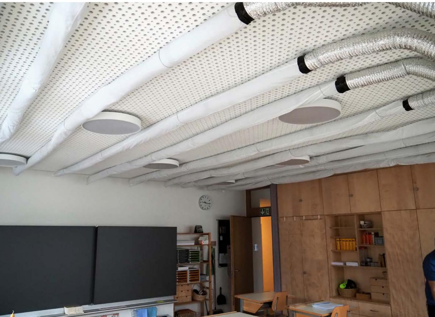
Bei der Versuchsanordnung im Unterrichtsraum der Schule in Lenzburg wird die Luft an der Decke über Röhren abgesogen, was Vorteile bringt.
