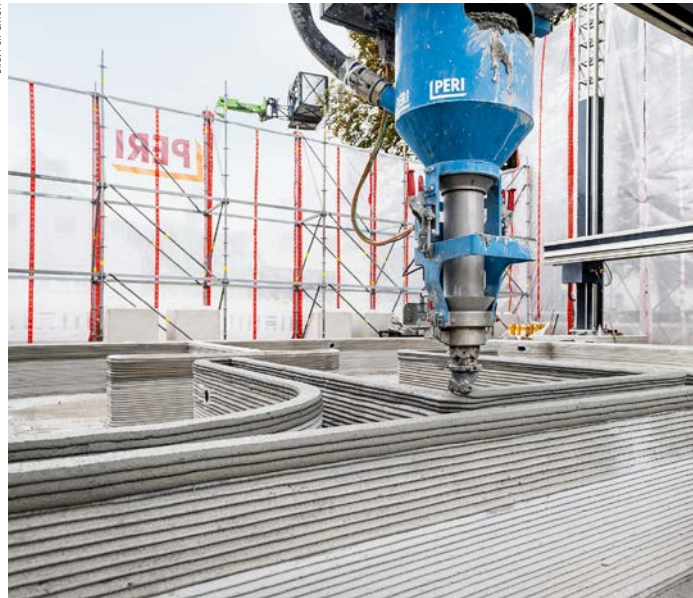
Das Gentry-Verfahren arbeitet mit orthogonal angeordneten Schienen, auf denen ein Schlitten gleitet.
