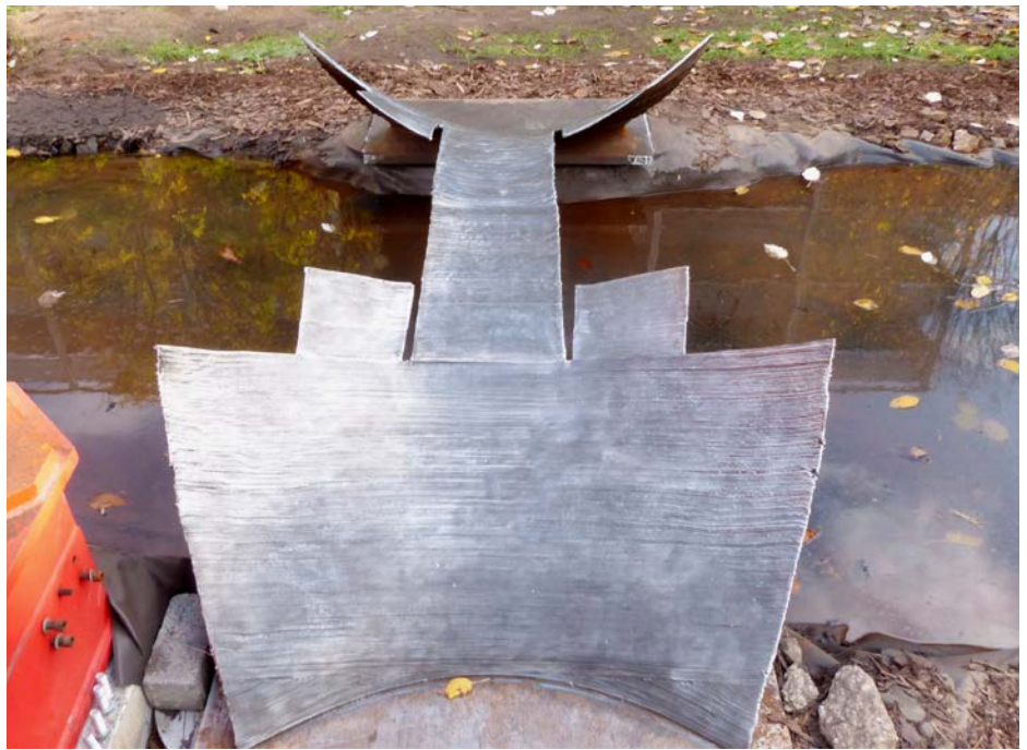
Seitenansicht der Brücke: Gut erkennbar sind die horizontalen Schichtlagen. Allerdings zeigte die TU Darmstadt, dass man auch geneigte Lagen erzeugen kann.
