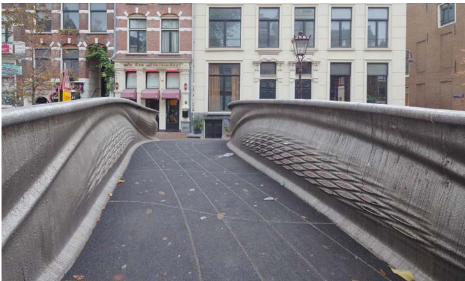
Die Brückenform hat im Grundriss eine geschwungene S-Form. Um die Brücke in ihrer Mitte leichter zu machen, sind die Geländergefache perforiert.
