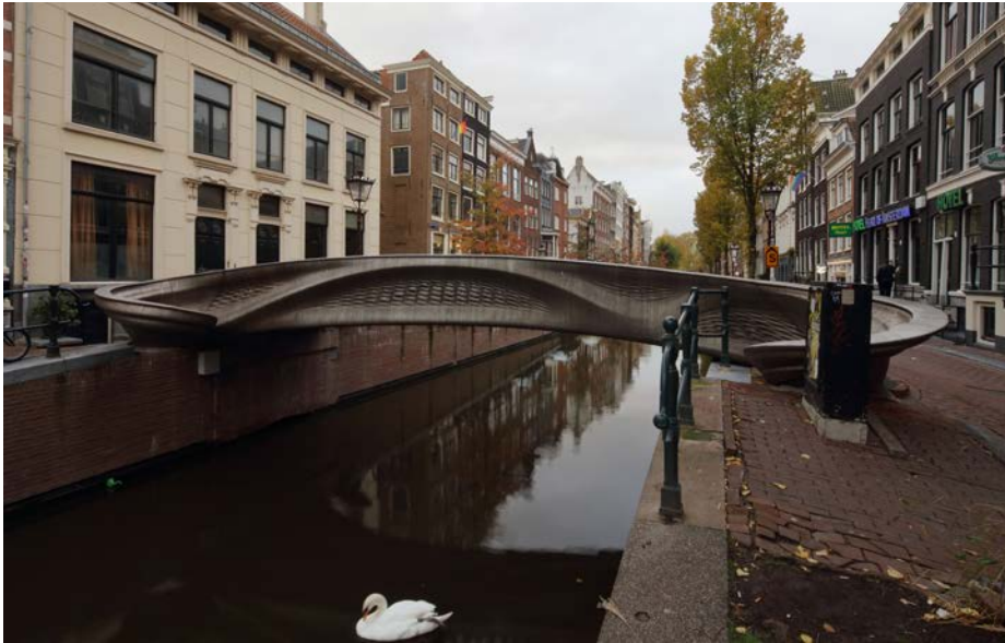
Die Brücke von MX 3D überquert in Amsterdam den Oudezijds Achterburgwal auf Höhe der Hausnummer 116 B. Der Blick aus nördlicher Richtung auf die Brücke.
