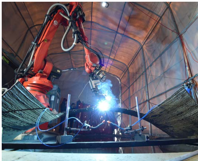
Für den 3D-Druck wurde auf den Roboterarm ein speziell entwickelter Lichtbogen-Schweißkopf montiert. Gearbeitet wurde in einem Zelt.
