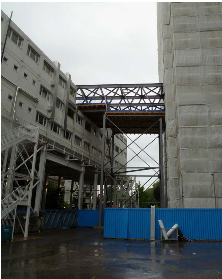
Der Bau der Passerelle vom Neubau des Hauptgebäudes (links) zur Kinderklinik erfolgte in einer Höhe von 18,6 Metern über Strassenniveau.
