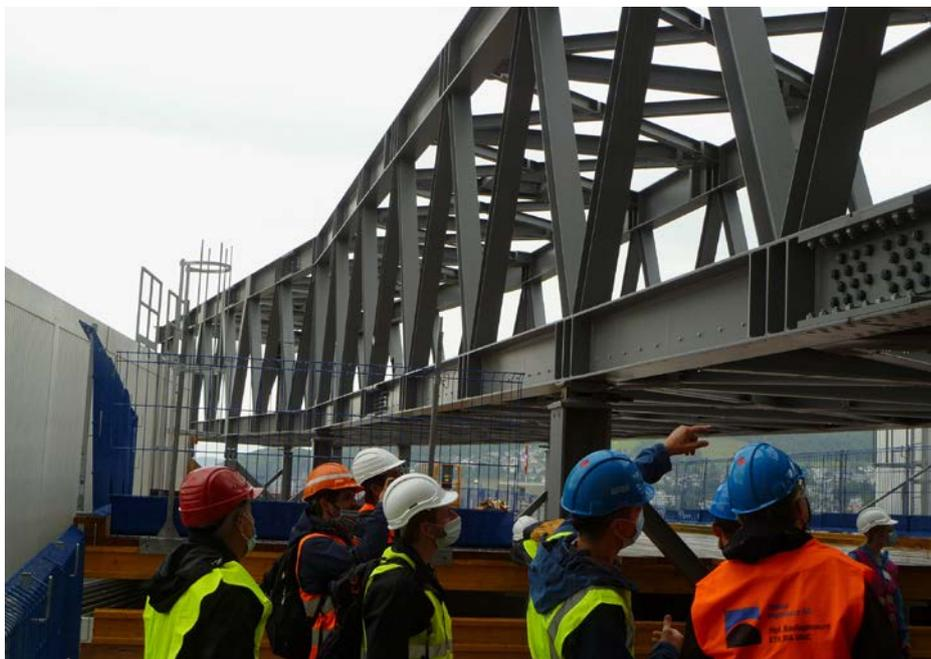
Baustellenbesichtigung beim im Ausbau befindlichen neuen Hauptgebäude des Inselspitals: Der Grossteil der Fachwerkteile der Passerelle ist bereits montiert.
