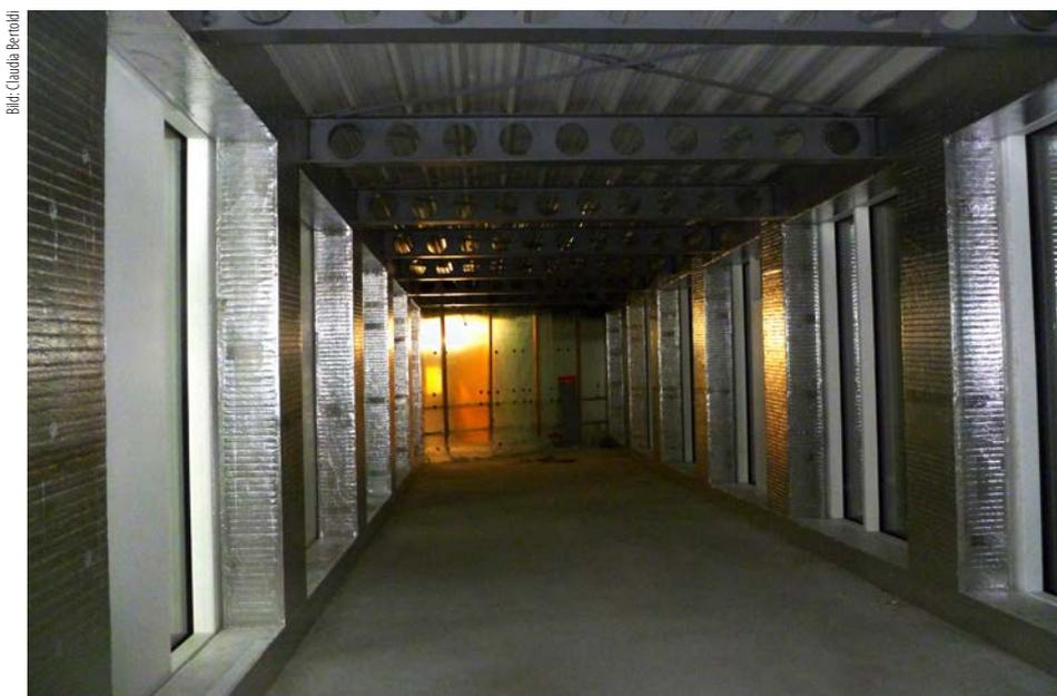
Eine der drei Passerellen vom neuen Hauptgebäude zum INO. Sie waren bereits im Juli fertig montiert und mussten zum Besichtigungszeitpunkt noch ausgebaut werden.
