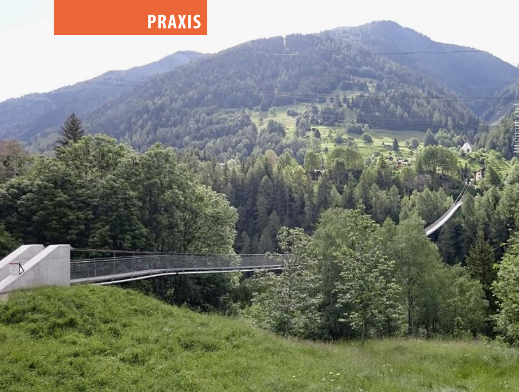
Die Gomsbridge zwischen Fürgangen und Mühlebach überquert die Lamma-Schlucht in 92 Metern Höhe über dem wilden Rotten.
