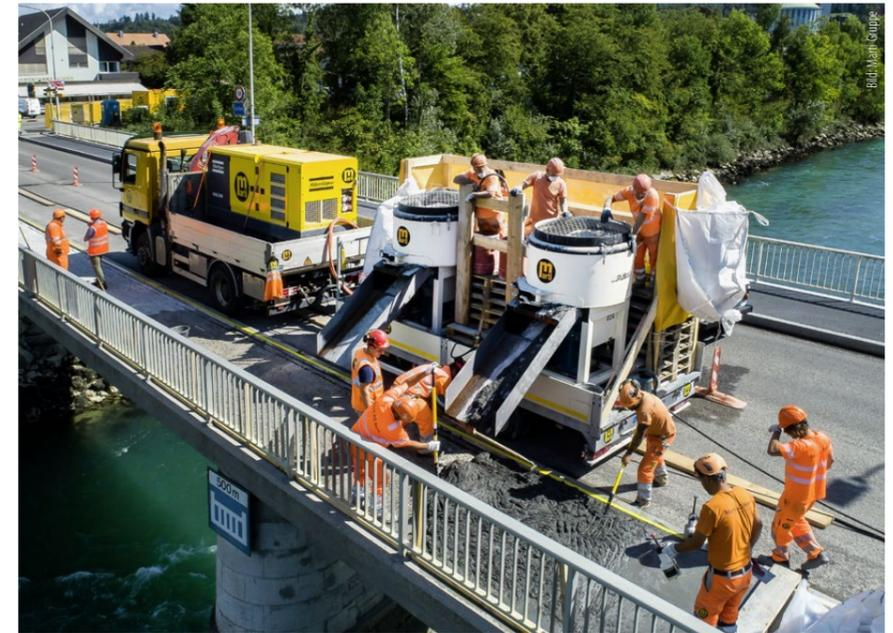
Mobile Betonanlage für Ultra-Hochleistungs-Faserbeton.
