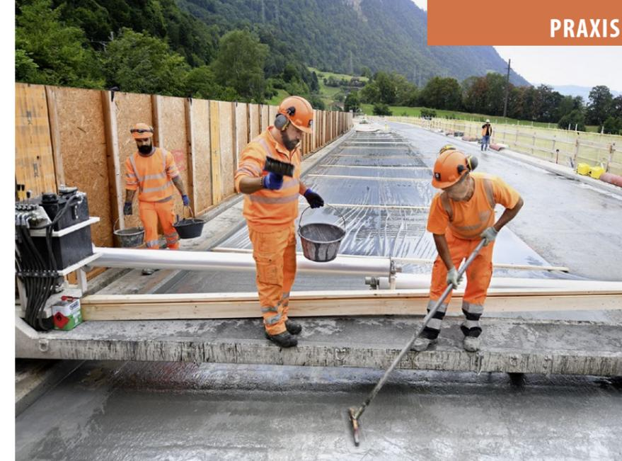
Abtalschieren und Nachbehandlung des UHPFB hinter dem Einbaufertiger.
