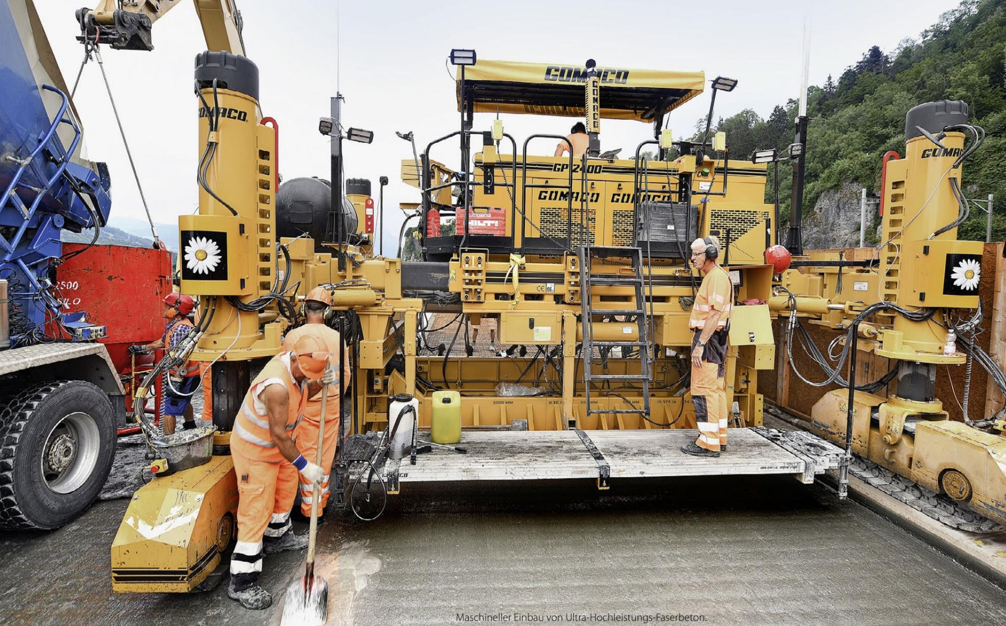
Maschineller Einbau von Ultra-Hochleistungs-Faserbeton.
