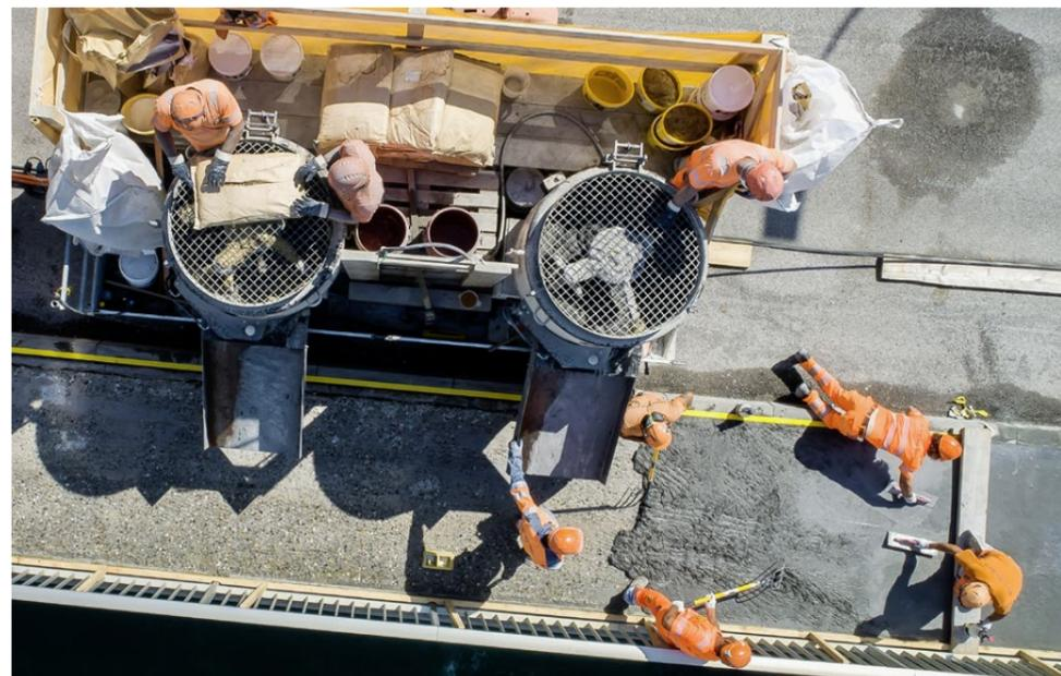
Einbau von UHFB mit Hilfe einer mobilen Betonanlage.
