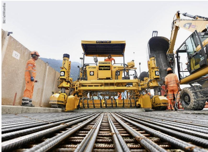
Ultra-Hochleistungs-Faserbeton wird maschinell eingebaut.
