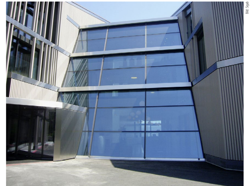
Einscheiben-Sicherheitsglas (ESG) bei Schrägverglasung.
