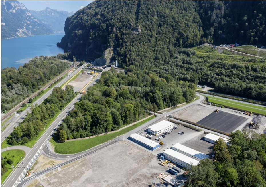
Mit Kosten von 436 Millionen Franken für die Instandsetzung inklusive neuem Sicherheitsstollen ist der Kerenzerbergtunnel auf der A3 am Walensee mit Abstand die grösste Baustelle im Glarnerland.
