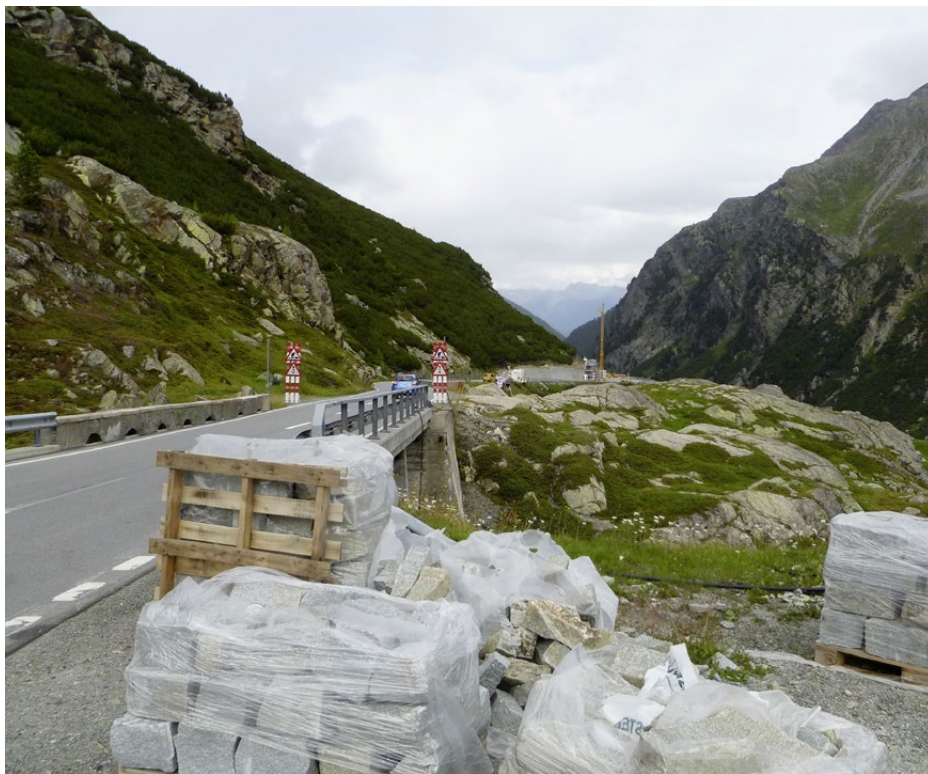
Insgesamt 783 Millionen Franken will der Kanton Graubünden wie hier am Flüelapass in den nächsten Jahren ins Strassennetz investieren.
